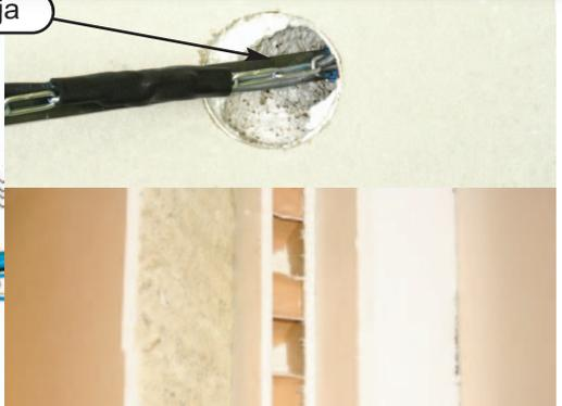
El Thermolatte 100305 permite efectuar el acoplamiento de sus tubos corrugados, en cualquier dirección, en poliestireno blanco o gris (cabezal térmico), lana de roca, lana de vidrio, tabiques de aislamiento en panel (con el cabezal de punta "PT2004» y la aguja "AS2001"(incluido)).
