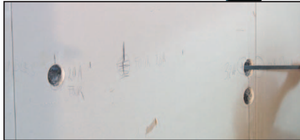
Efectúe sus perforaciones en poliestireno blanco o gris, en todas las direcciones. Pasa por: 1 conducto de Ø 25 o 1 de Ø 20 o 2 de Ø 16. La forma biselada del cabezal calefactor (cabezal PC2005) permite presionar el cabezal contra la placa de yeso adherido al revestimiento sin crear puentes térmicos (el aislamiento permanece detrás de la canalización).
